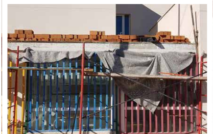
Mejoras en cubierta de colegio
