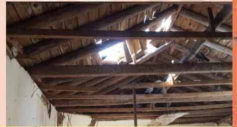
Recuperación de la cubierta de Torre
