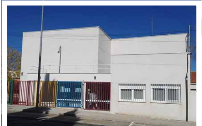
Mejoras en cubierta de colegio
