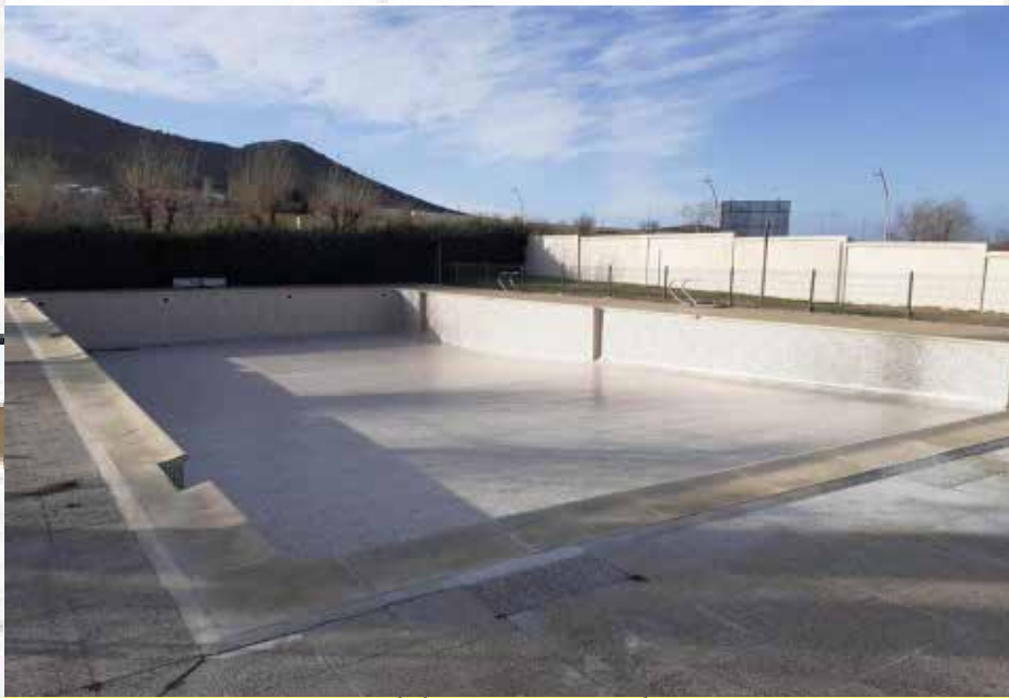
Impermeabilización a través de Linner
