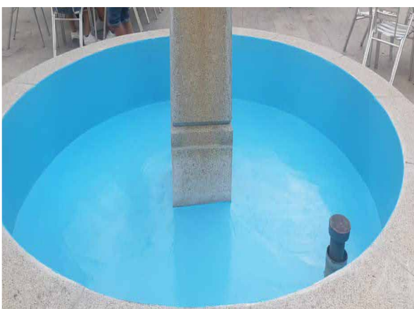
Impermeabilización de fuentes
