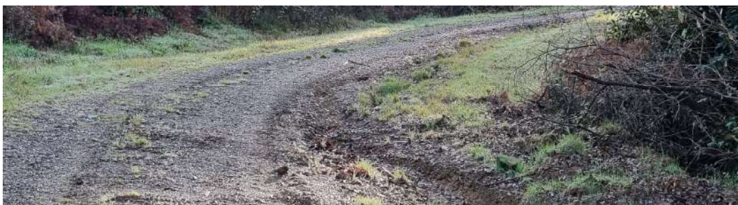
Figura 41. Fotografía da estrada común a alternativa 2 e 4.
