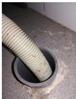
**Desagües de lavavajillas y lavadoras mal sellados, demasiado hueco entre ambos tubos.**
