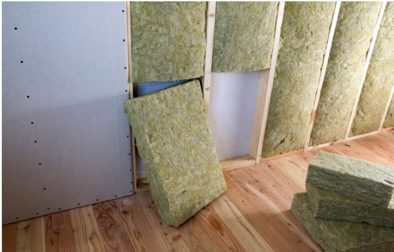
Trasdosados de "Pladur" o cartón-yeso
