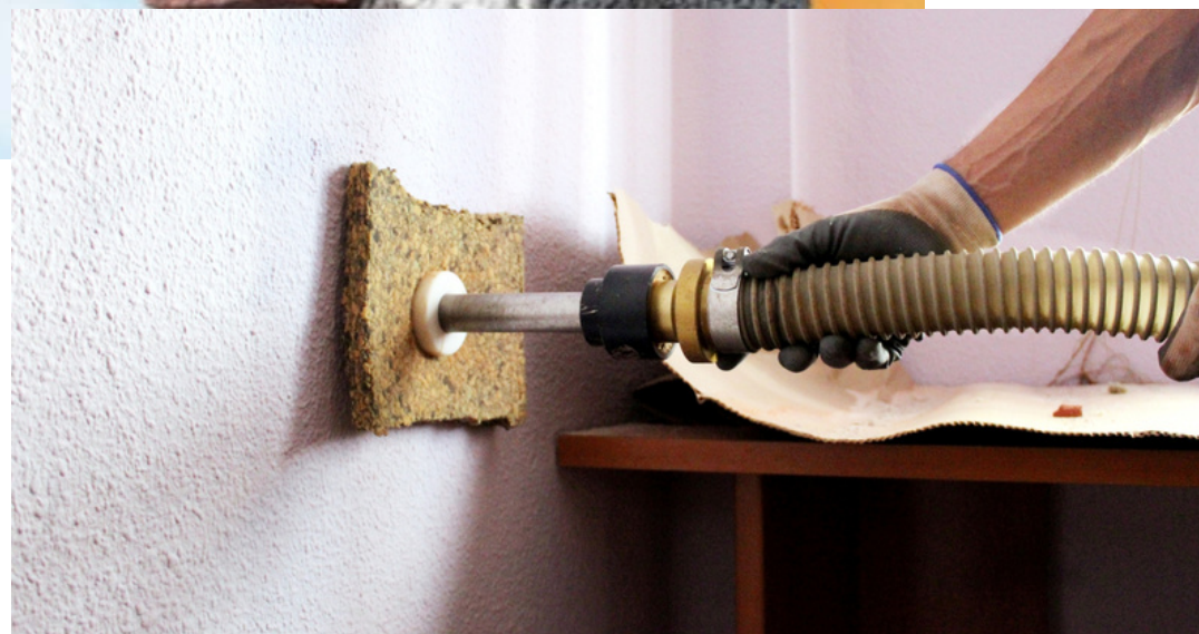
Insuflado o proyectado de cámaras de muros exteriores
