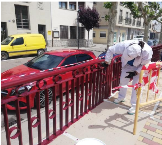
Lijado y pintura de barandillas metálicas del parque infantil ubicado en la calle La Rosa
