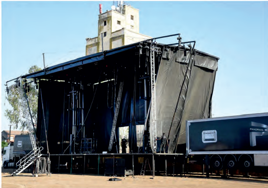
Escenario de Torrejón en pleno montaje. Tiene 30 metros de ancho, 11 de largo y 10 de alto. Palma
