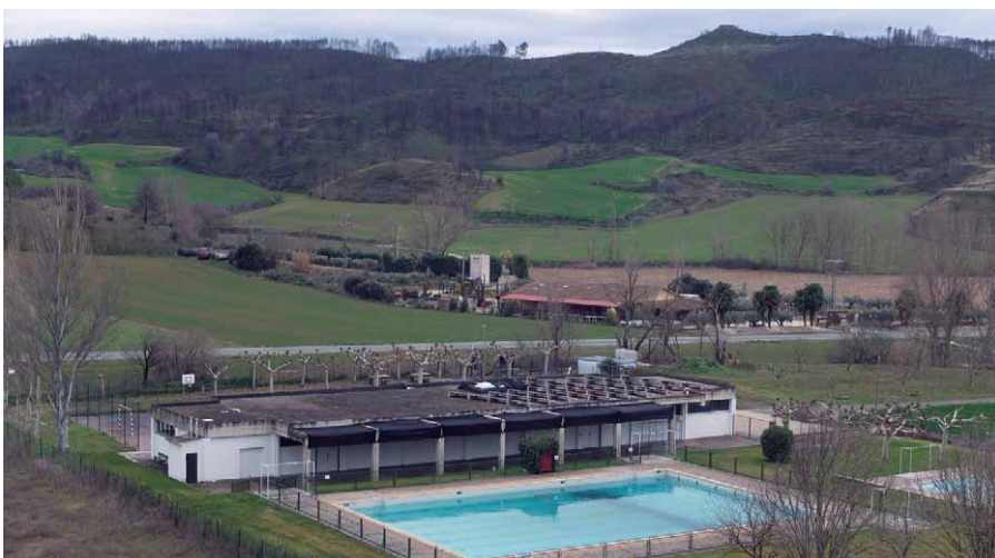
Las placas fotovoltaicas, ocupando la mitad de la cubierta del edificio de las piscinas de Obanos
