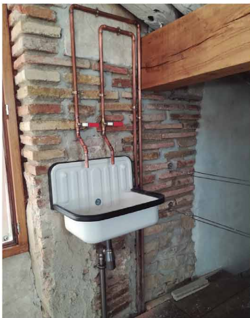
Instalación de lavabo
