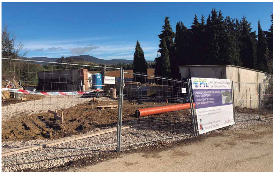
Obras de ampliación del cementerio de Obanos, financiadas en un 80% por el PIL del Gobierno de Navarra
