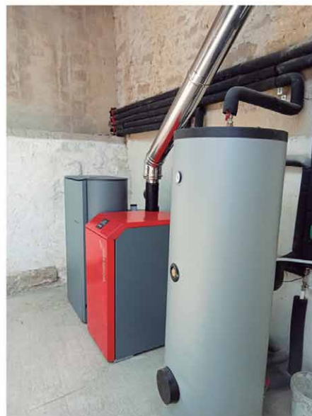
Instalación de caldera de pellet con depósito
