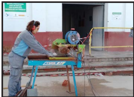
Isa cortando baldosas
