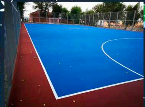
Remodelación Pista fútbol sala
