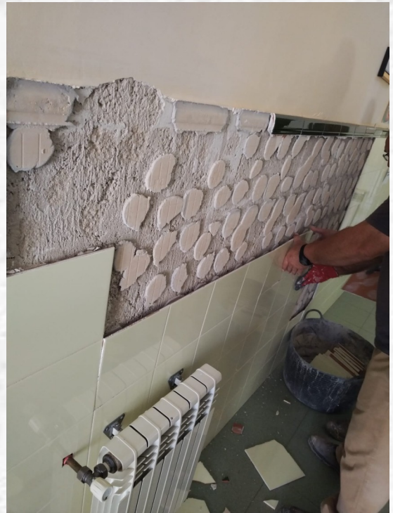
Saneamiento de humedades y alicatado en el centro médico.
