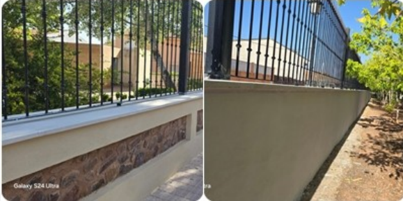
Saneario de humedades y sustitución de vierteaguas en parque municipal.
