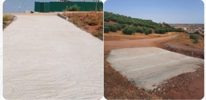
Arreglo camino del mirador con hormigón y badenes.
